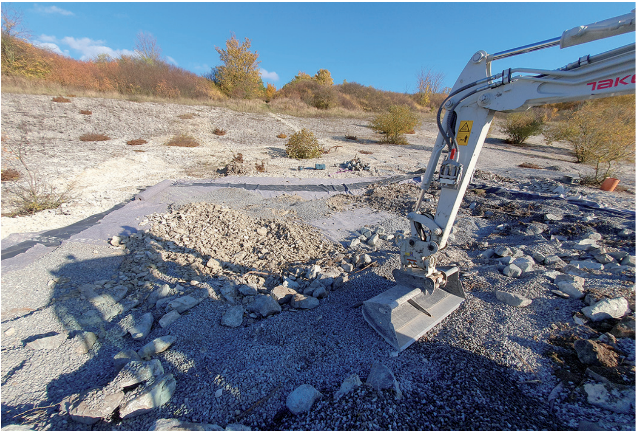
Abbildung 4: Anlage eines ablassbaren Foliengewässers. (Foto: ÖNSA/Valentin Dienst)
