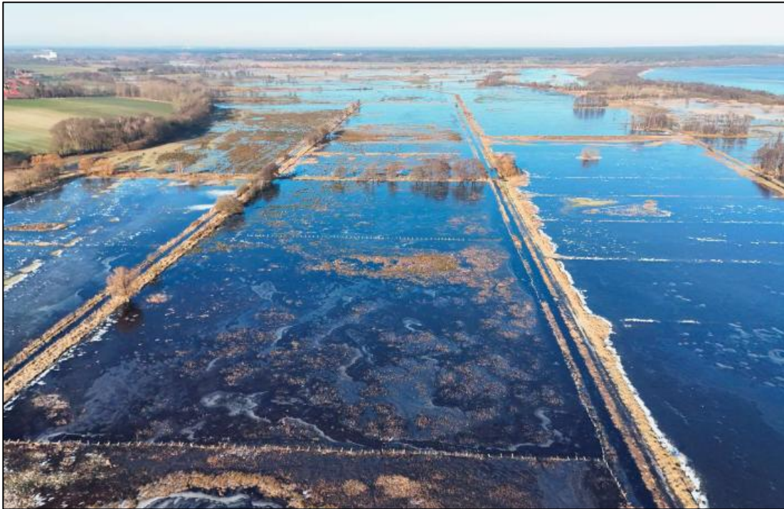
Abb. 11: südlicher Bereich des Untersuchungsgebietes NSG Meerbruchswiesen während der Überschwemmungen am 9.1.2024 (Foto: ÖSSM E.V., mit Genehmigung der Region Hannover)
