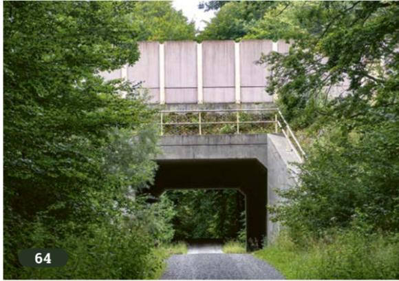
**Abb. 64:** Eine über Jahre hinweg genutzte Querungsstelle der Mopsfledermaus und anderer Fledermausarten an der BAB 3 im Guttenberger Wald in Form eines großdimensionierten Durchlasses mit Forstwegequerung
