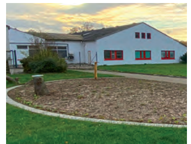
Fertig umgestaltete Fläche bei Kuchenmeister.
