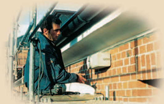
Anbringung eines Mauerseglerkastens
